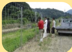
侵入防止柵の共同設置作業
