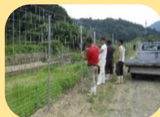
侵入防止柵の共同設置作業
